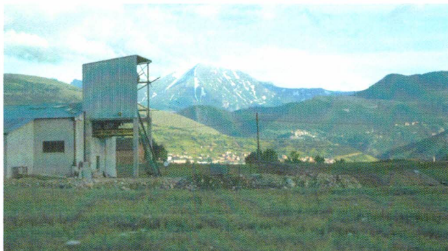
Berge, Wälder, ein wildromantisches Panorama, wenn die Kriegsschäden nicht überall noch sichtbar wären
